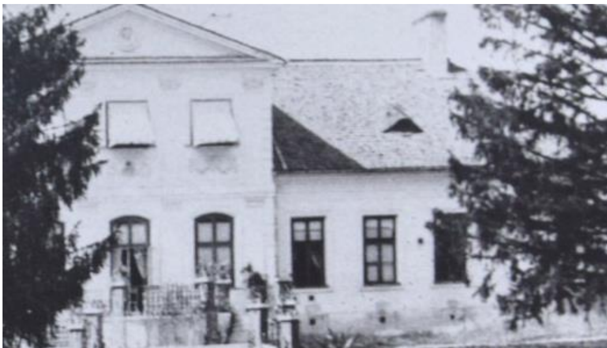
Fragment fotografii – widoczne pokrycie gontem, markizy w oknach ryzalitu oraz ciemne stolarki okienne.
