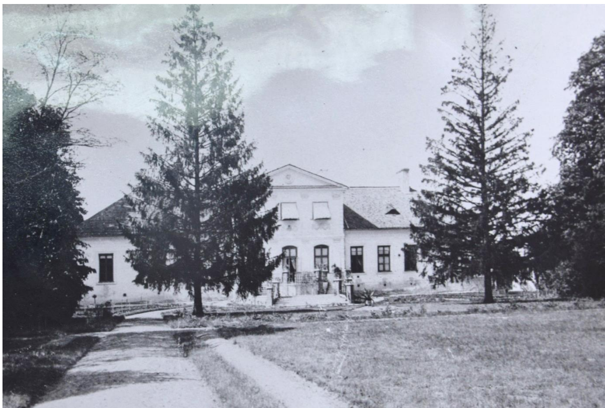
Elewacja ogrodowa pałacu w Dębinkach w okresie międzywojennym. Widoczne istotne szczegóły architektury i wystroju – dach pokryty gontem, markizy w oknach ryzalitu drugiej kondygnacji oraz stolarka okienna w ciemnym (zielonym?) kolorze. Fotografia pochodzi ze studium historyczno-architektonicznego W. Chodkowskiej i M. Przytockiej z 1982 roku (z zasobów MWKZ / delegatura w Ostrołęce).
