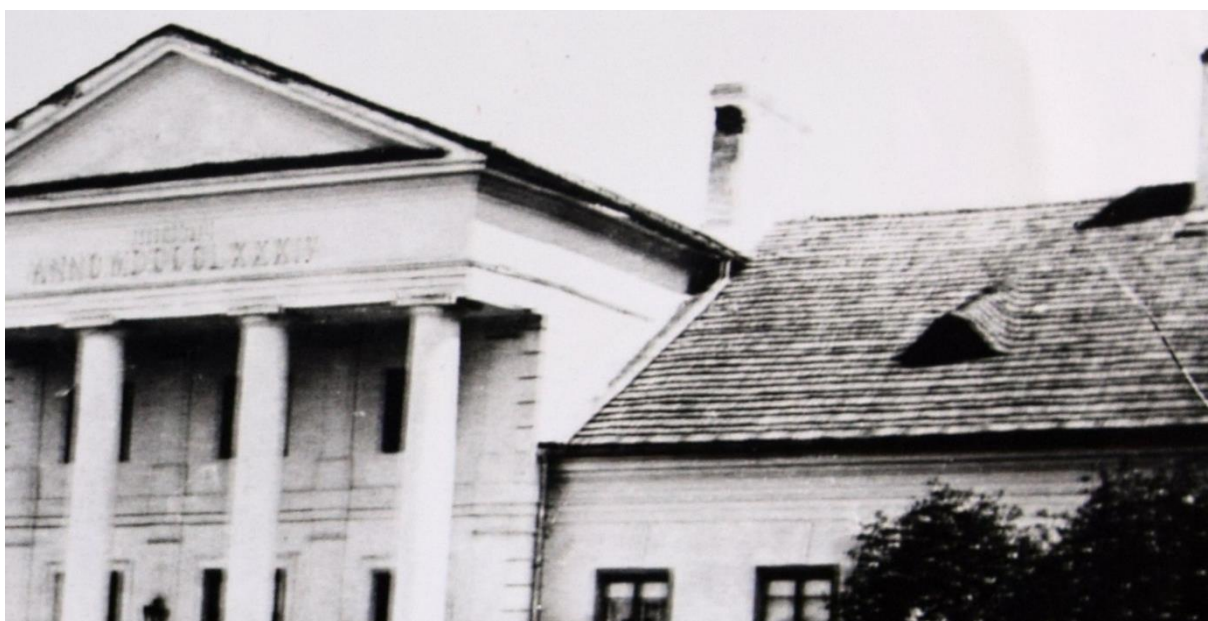
Fragment fotografii – widoczne wyraźne kolejne rzędy gontu układanego metodą na styk.
