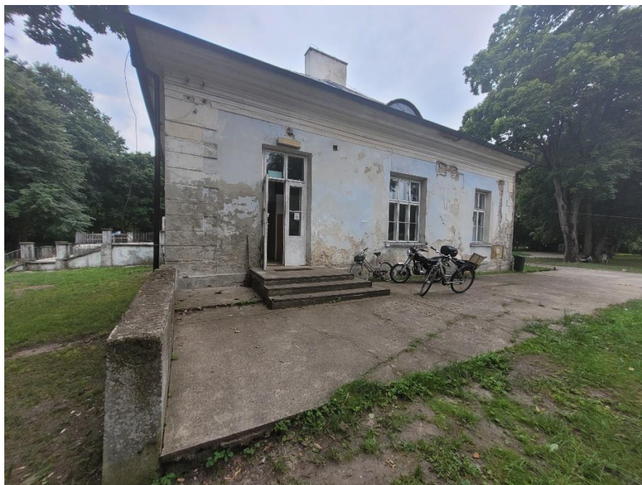
Fot. 26 Północnozachodnia elewacja Pałacu. Widoczne odspojenia tynków i cegieł, ślady aktywności wody. Na opasce widoczny rozrost roślin zielnych. Na murku oraz strefie cokołu widoczna aktywność glonów, mszaków i porostów. Fot. Magdalena Dyda
