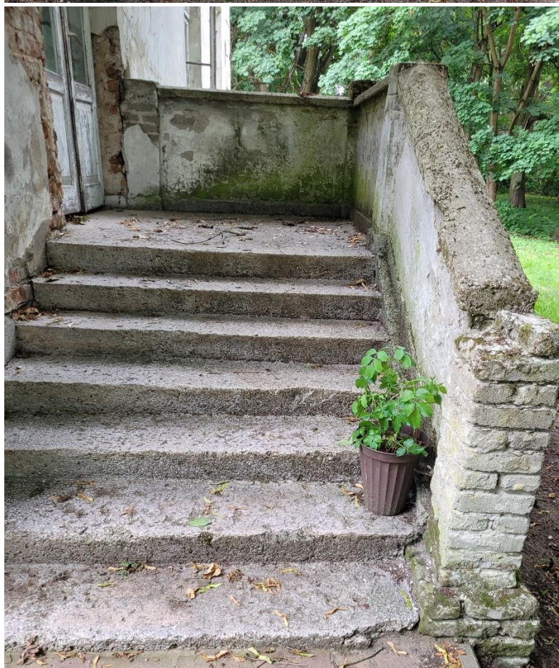
Fot. 12. Południowowschodnia elewacja przedmiotowego budynku. Na murku przy schodach widoczne intensywne zanieczyszczenia, korozja biologiczna: wzrost glonów, mszaków, porostów. Fot. Magdalena Dyda
