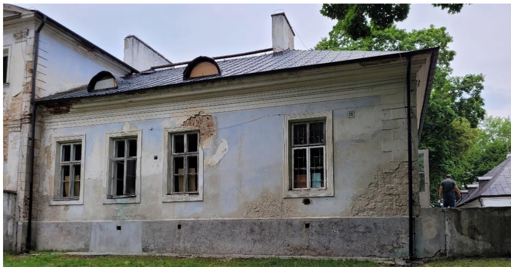
Fot. 14. Część wschodnia elewacji południowej. Widoczne odspojenia tynków i cegieł, powłok malarskich ślady aktywności wody, szczególnie wzdłuż rur spustowych, pod okienkami dachowymi. W strefie przycokołowej i na opasce widoczna biokorozja: wzrost glonów, mszaków i porostów Fot. Magdalena Dyda
