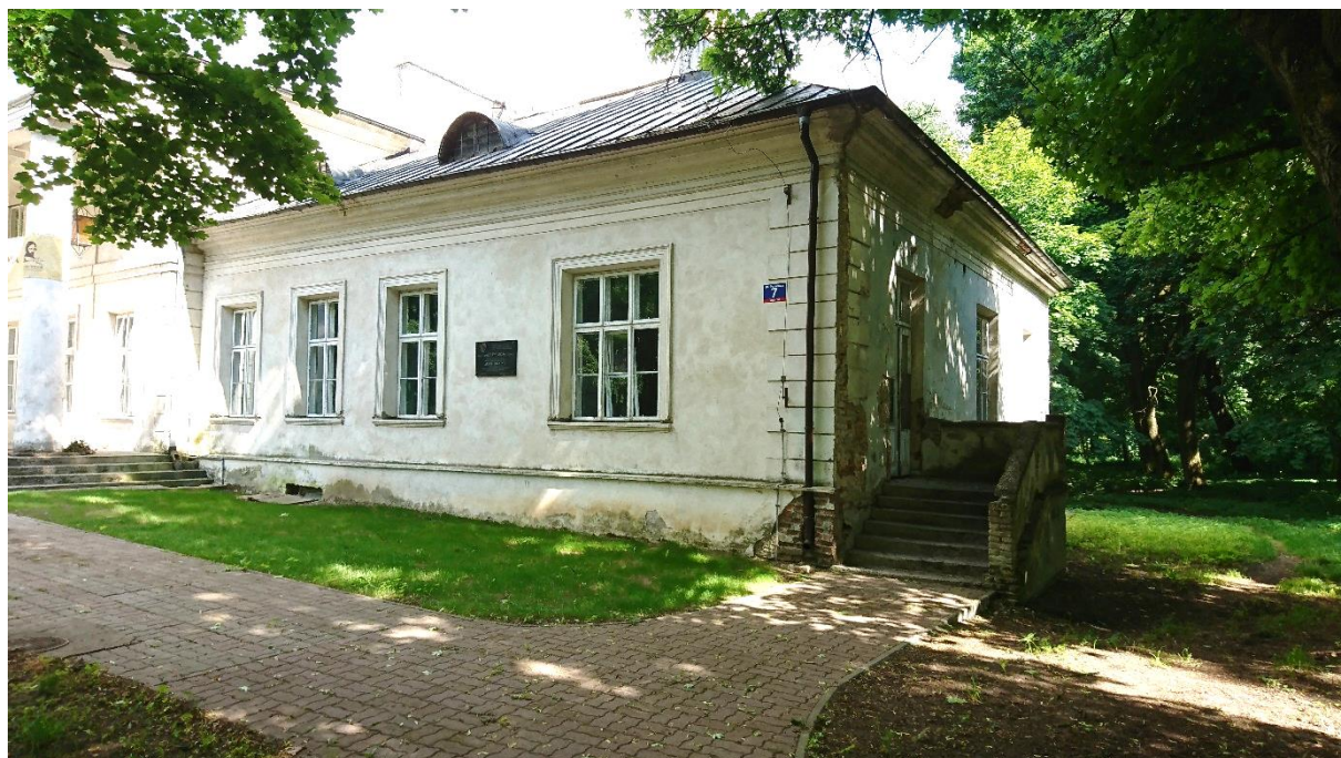
Fot. 21. Fragment zachodniej części korpusu głównego – widoczne zniszczenia tynku w obrębie cokołu i w narożniku oraz wtórnie dostawione schody w elewacji szczytowej.
