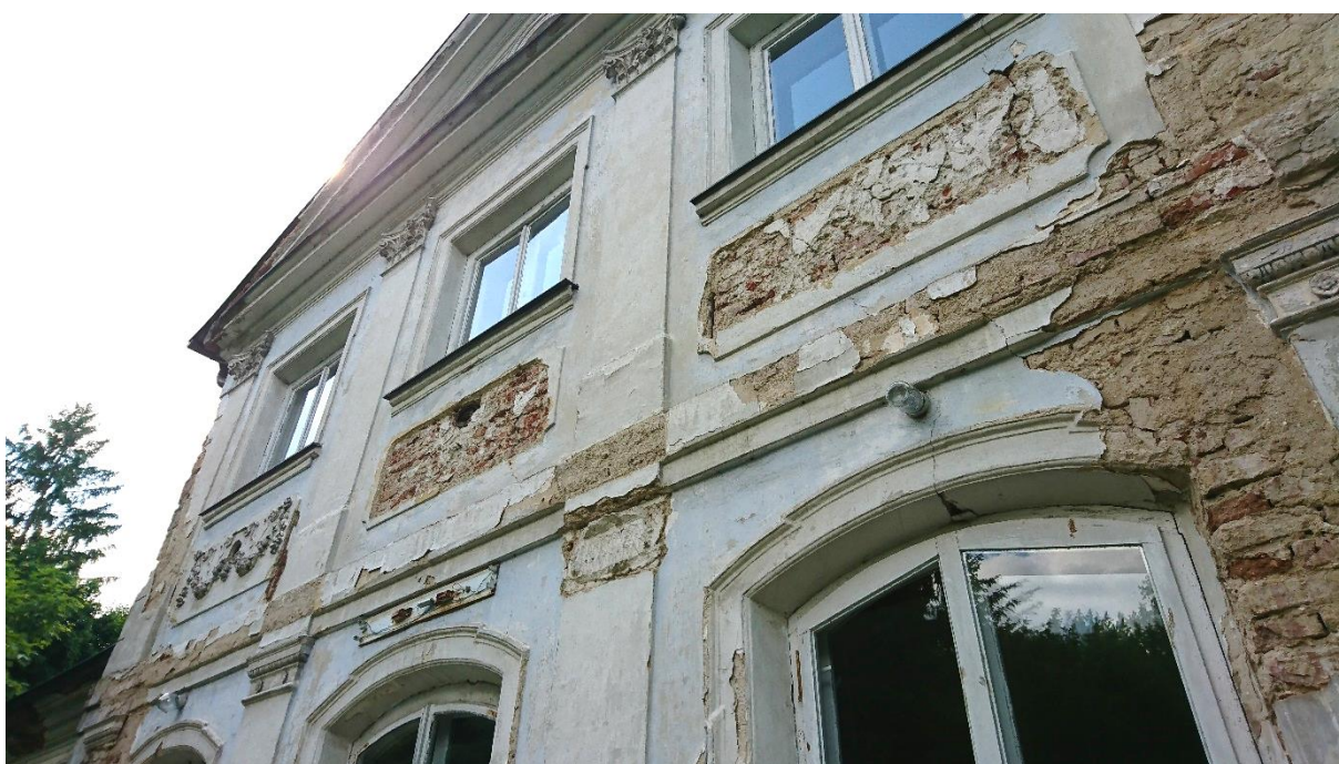
Fot. 37. Elewacja ryzalitu od strony ogrodu – bardzo zły stan zachowania detali sztukatorskich.
