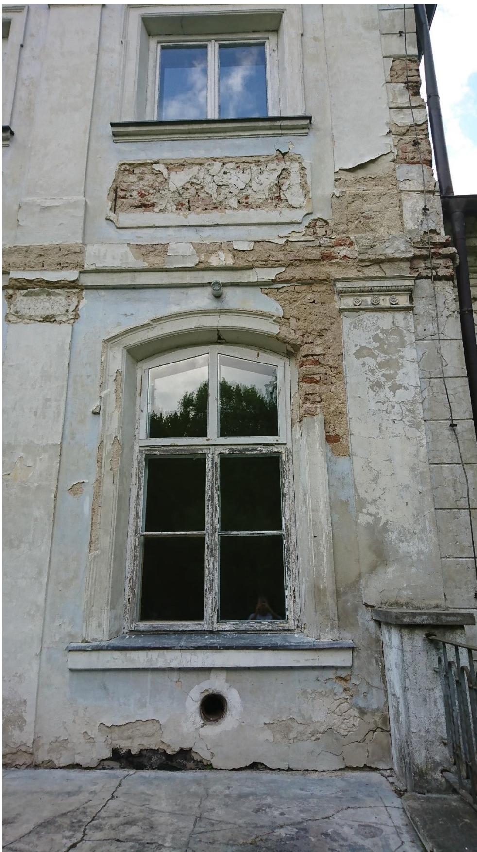
Fot. 38. Elewacja ryzalitu od strony ogrodu – bardzo zły stan zachowania detali sztukatorskich.
