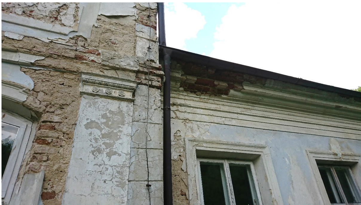
Fot. 36. Fragment elewacji ogrodowej w rejonie narożnika ryzalitu – widoczna bardzo rozległa i intensywna erozja wypraw tynkarskich i detalu sztukatorskiego.
