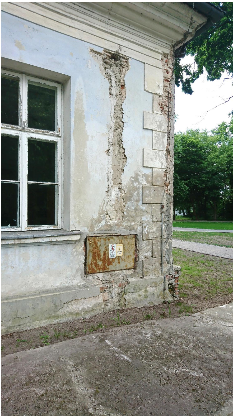
Fot. 25. Zniszczenia w obrębie narożnika – erozja tynków spowodowana zawilgoceniem oraz wtórnymi przebiciami.
