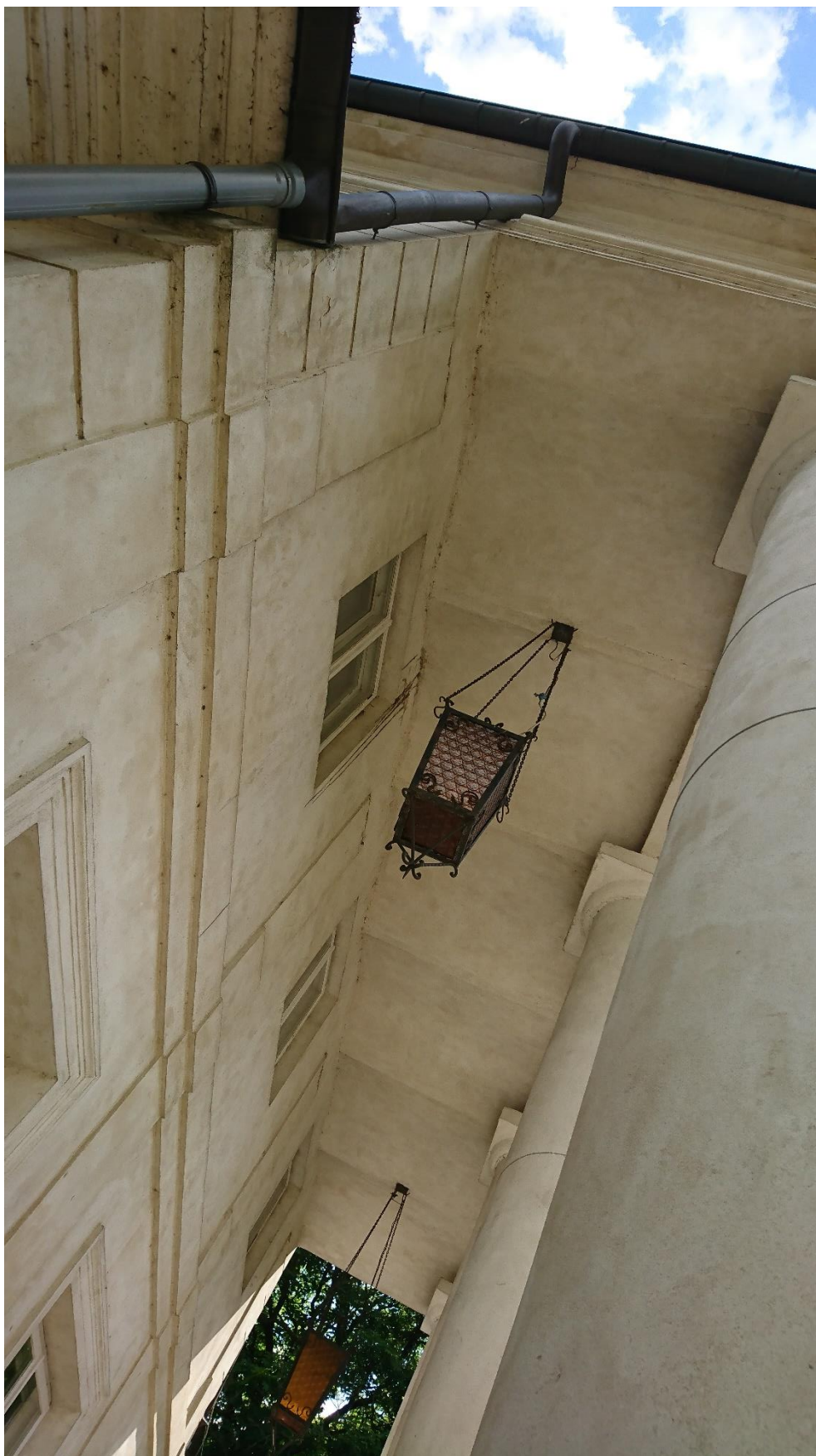
Fot. 32. Wnętrze portyku – stan zachowania. Widoczny brak kapiteł pilastrów między oknami drugiej kondygnacji.
