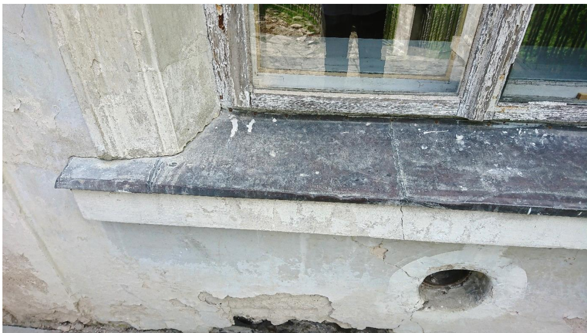
Fot. 28. Detal w elewacji frontowej – stan zachowania obróbek blacharskich.
