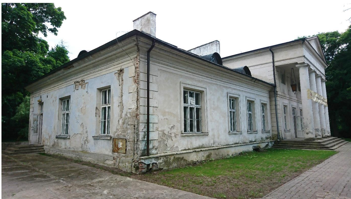
Fot. 20. Wschodnia część korpusu głównego pałacu – rozległe i silne zniszczenia wypraw tynkarskich i detalu sztuka- torskiego. Na pierwszym planie widoczny murek przybudowany bez przewiązania do cokotu elewacji frontowej.
