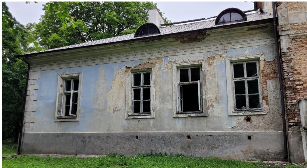
Fot. 15. Część zachodnia elewacji południowej. Widoczne odspojenia tynków i cegieł, powłok malarskich ślady aktywności wody, szczególnie wzdłuż rur spustowych, pod okienkami dachowymi. W strefie przycokołowej i na opasce widoczna biokorozja: wzrost glonów, mszaków i porostów Fot. Magdalena Dyda
