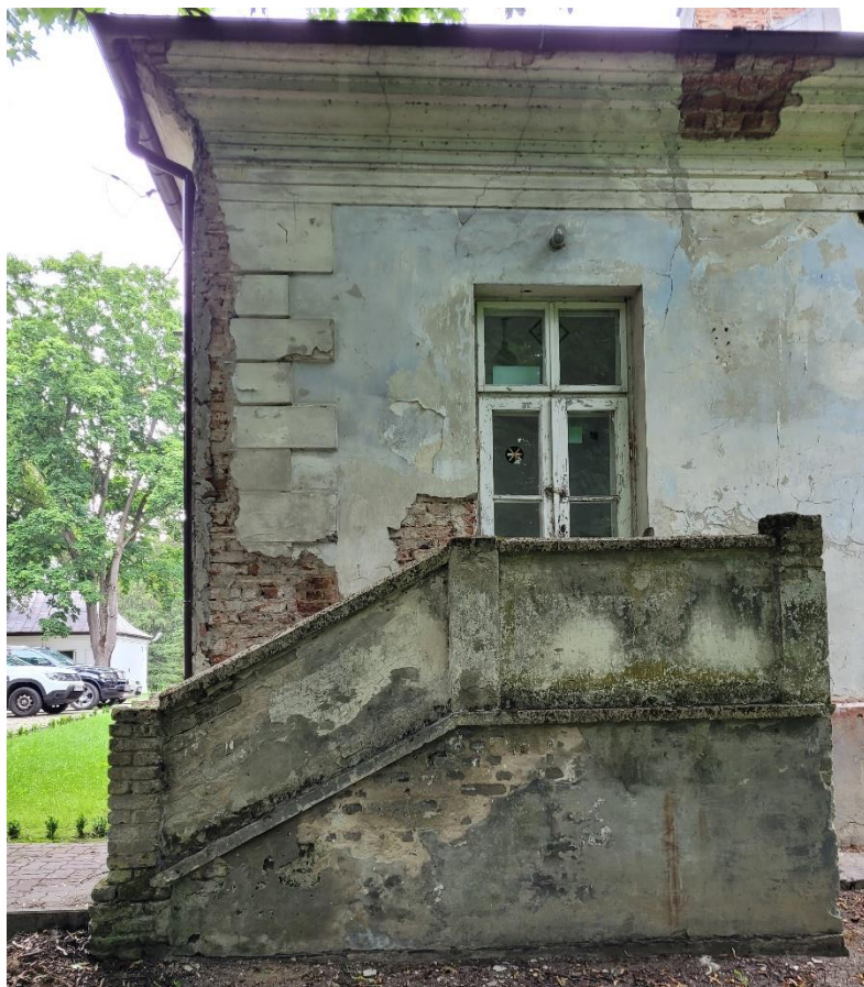
Fot. 11. Południowowschodnia elewacja przedmiotowego budynku. Na murku wzdłuż schodów widoczne intensywne zanieczyszczenia, korozja biologiczna: wzrost glonów, mszaków, porostów. Fot. Magdalena Dyda
