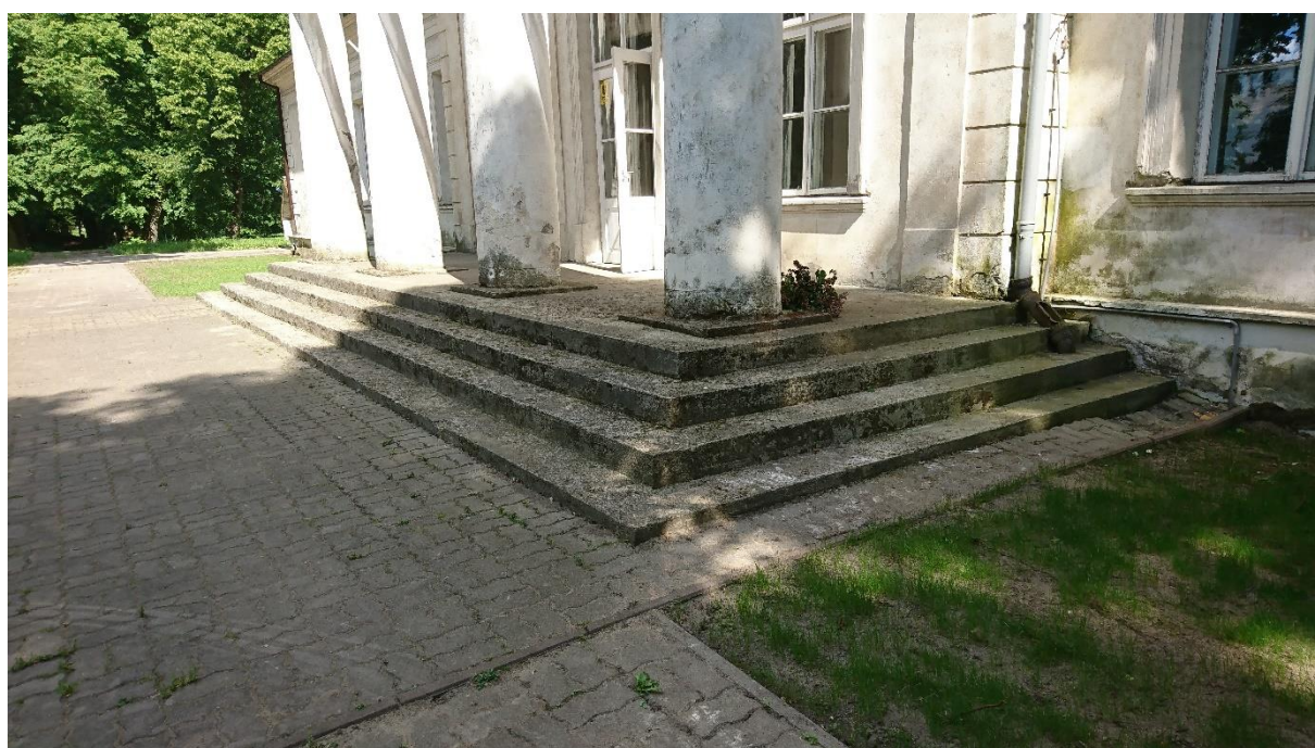
Fot. 22. Schody – stylobat portyku kolumnowego. Element wtórnie wykonany z betonu.
