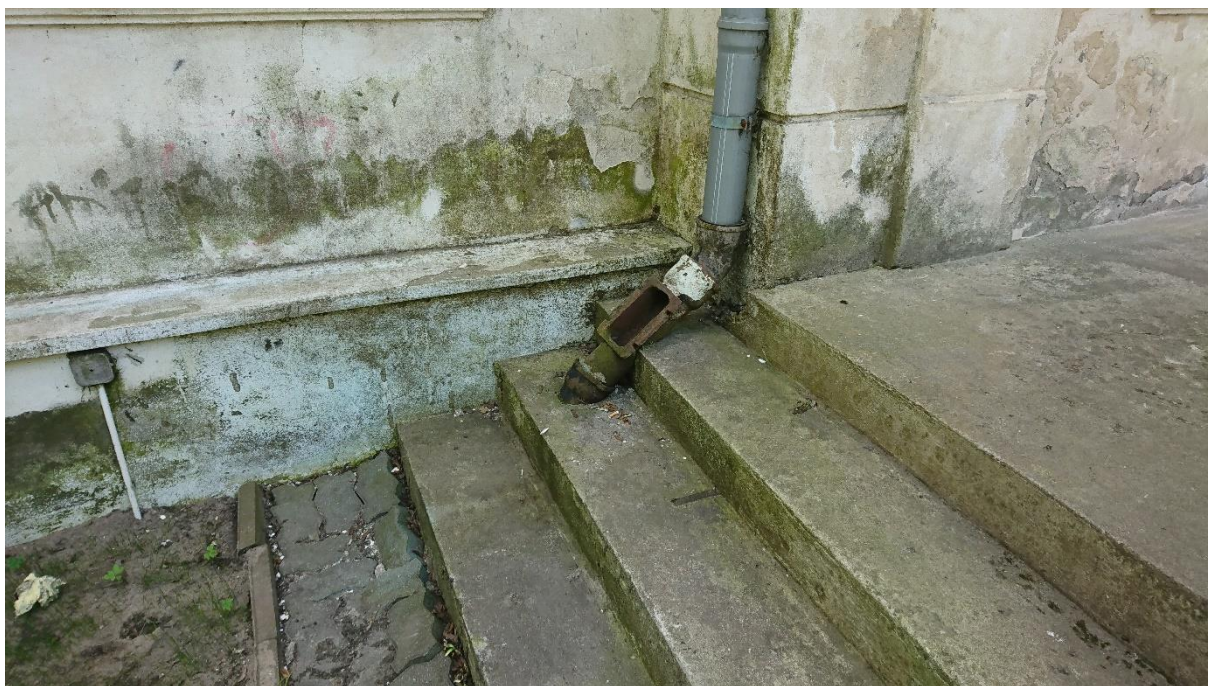
Fot. 23. Sposób poprowadzenia rury spustowej w rejonie portyku. Zwracają uwagę silne nawarstwienia biologiczne.
