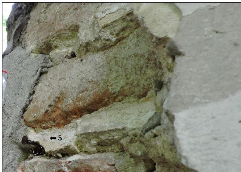
Fot. 6. Widok miejsca pobrania próbki nr 02 oraz oznaczenie 5 warstwy technologicznej, lipiec/sierpień 2022r.
