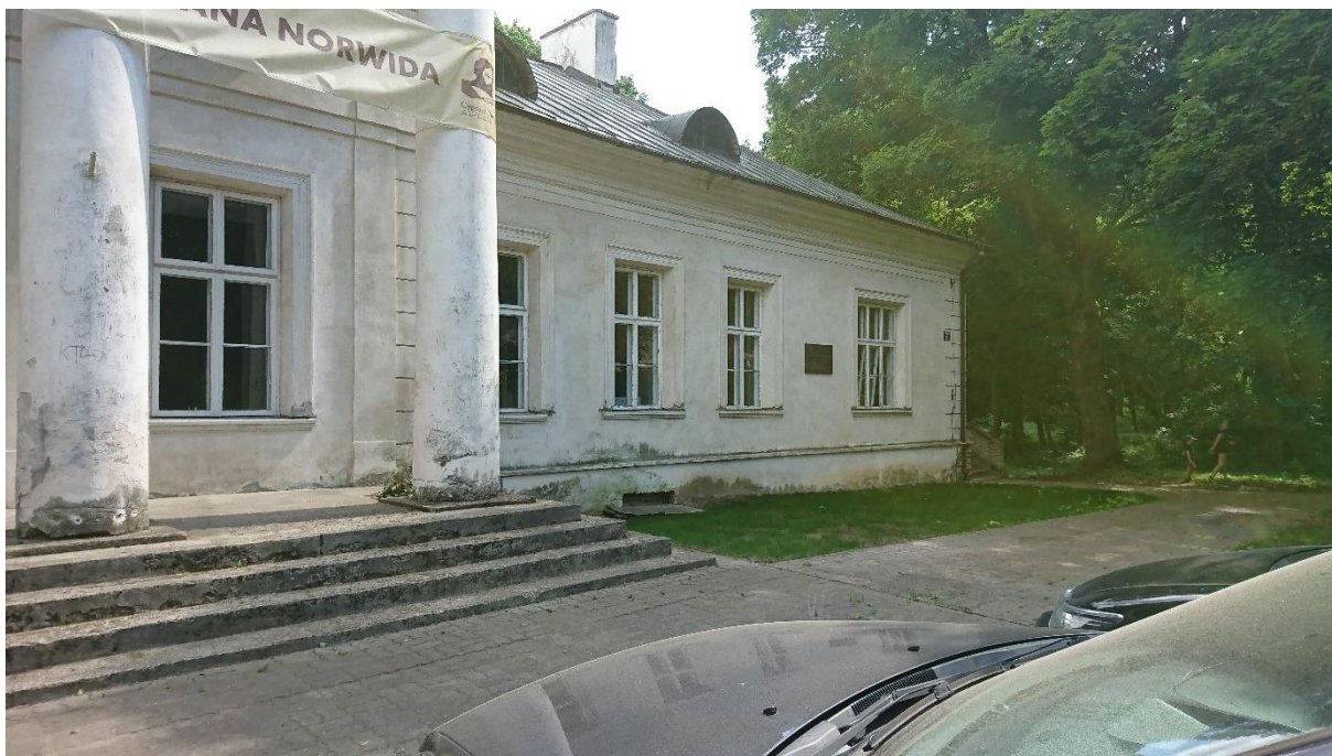
Fot. 19. Fragment elewacji frontowej pałacu – część zachodnia. Widoczne rozległe uszkodzenia tynków, zawilgoce- nie i porost glonów.
