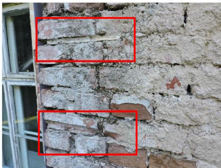
Fot. 79. Elewacja tylna, ryzalit – fragment z widocznym żłobkowaniem wążku ceglanego w celu wykonania boniowania. W górnym prostokącie relikty zaprawy i warstwy malarskiej żółtej, w dolnym podcięcie w cegle półwałkowe.
