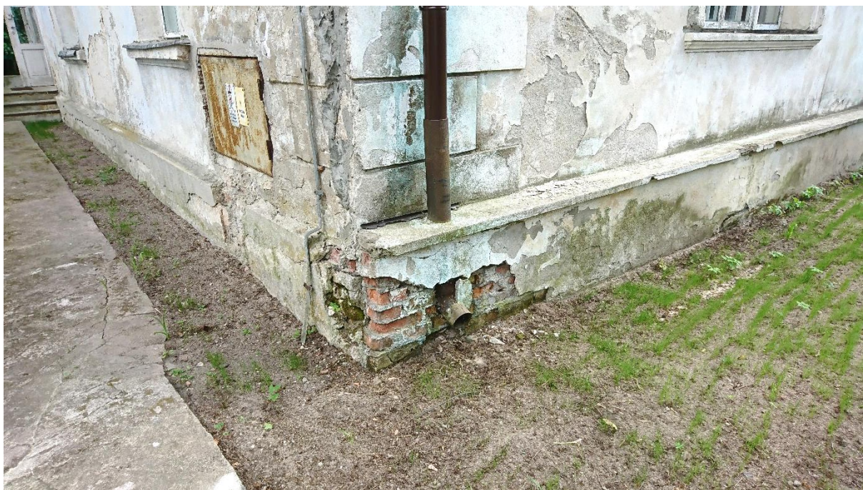
Fot. 26. Stan zachowania narożnika – widoczny dobudowany cokół i sposób poprowadzenia rury spustowej – woda wydostaje się bezpośrednio pod elewację.
