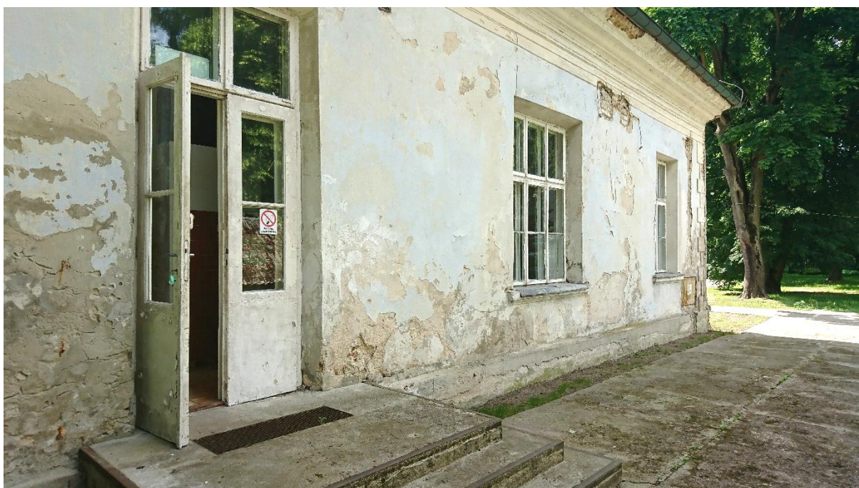
Fot. 24. Erozja tynków w elewacji szczytowej od strony wschodniej. Na pierwszym planie widoczna wtórna wylewka betonowa oraz schody z podestem prowadzące do wtórnych drzwi.
