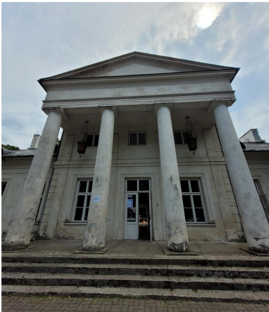
Fot. 2. Środkowy fragment północnej elewacji przedmiotowego budynku. Widoczne spękania i odspojenia tynku, powłok malarskich, biokorozja schodów wejściowych. Fot. Magdalena Dyda
