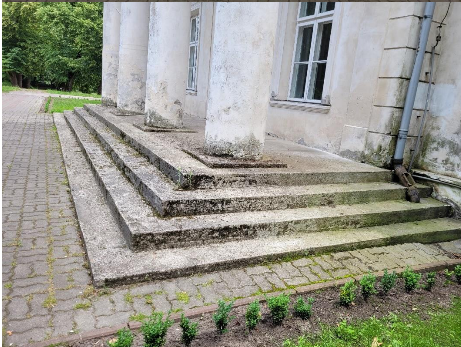
Fot. 3. Schody wejściowe od strony północnej Pałacu z widoczną biokorozją – pokryte warstwą glonów, mszakami i porostami, miejscami widoczne rośliny zielne. Widoczne spękania i odspojenia tynku i powłok malarskich w dolnej części elewacji. Ujście rynnę zamontowane w schodach. Fot. Magdalena Dyda
