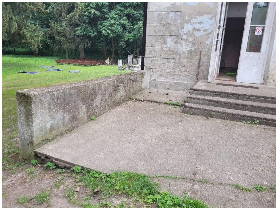
Fot. 27 Północnozachodnia elewacja Pałacu. Widoczne odspojenia tynków i cegieł, ślady aktywności wody. Na opasce widoczny rozrost roślin zielnych. Na murku oraz strefie cokołu widoczna aktywność glonów, mszaków i porostów. Fot. Magdalena Dyda
