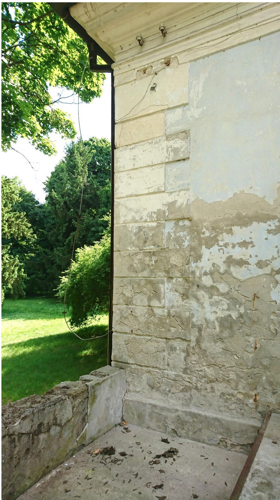
Fot. 30. Fragment narożnika elewacji szczytowej od wschodu i elewacji ogrodowej – silna erozja wypraw tynkarskich. Widoczne zachowane dwa izolatory ceramiczne.
