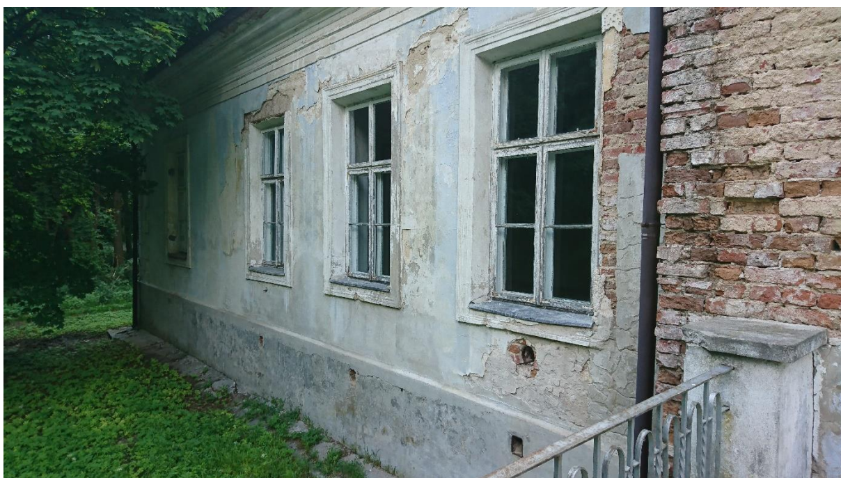
Fot. 34. Zachodni fragment elewacji ogrodowej – stan zachowania. Widoczne wtórne wyprawy tynkarskie malowane na kolor błękitny oraz rozległe zniszczenia spowodowane zawilgoceniem i uszkodzeniami obróbek blacharskich.
