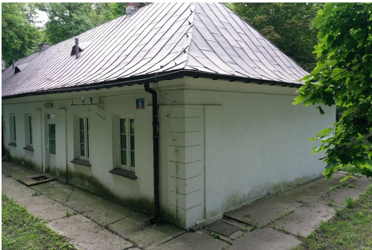
Fot. 42. Oficyna po stronie zachodniej dziedzińca – ściana szczytowa po stronie północnej. Widoczne obfite nawarstwienia biologiczne na cokole.
