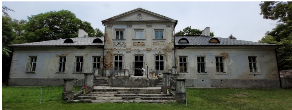
Fot. 13. Elewacja południowa. Widoczne odspojenia tynków i cegieł, powłok malarskich ślady aktywności wody. Fot. Magdalena Dyda
