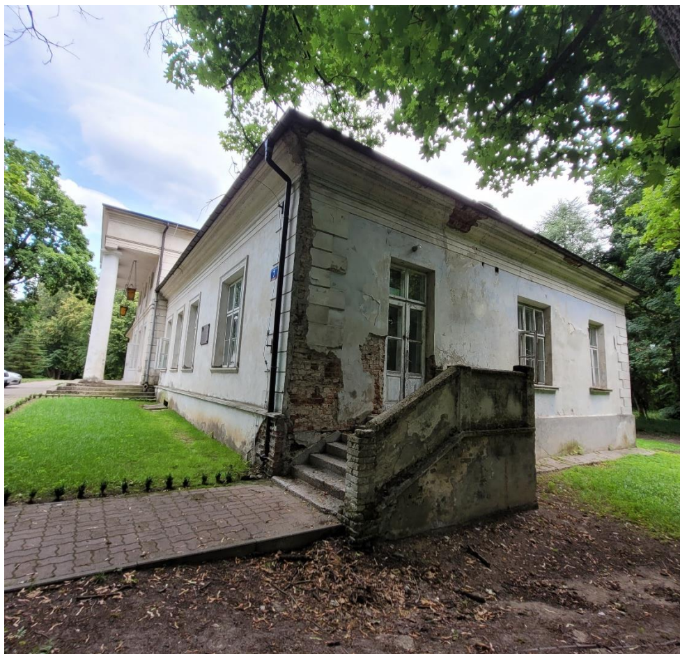
Fot. 9. Narożnik południowoschodni budynku. Widoczne odspojenia tynków i cegieł wzdłuż rur spustowych. Na opasce widoczny rozrost roślin zielnych, na schodach korozja biologiczna: wzrost glonów, mszaków, porostów i intensywne zanieczyszczenia. Fot. Magdalena Dyda
