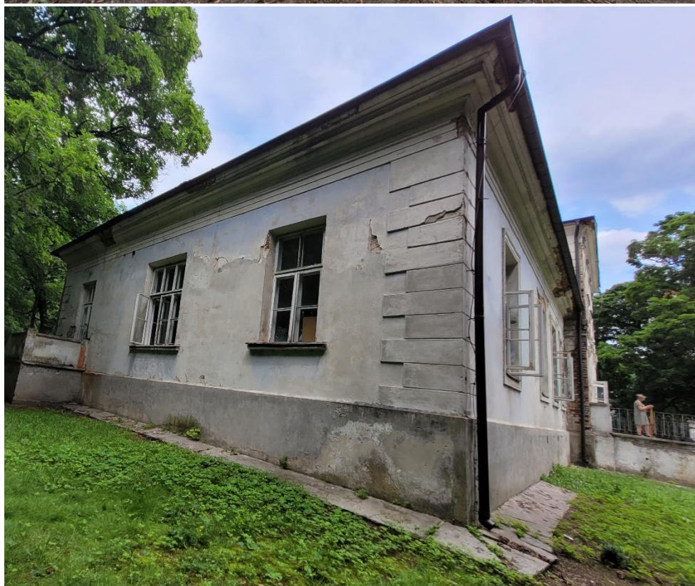
Fot. 10. Południowoschodnia elewacja przedmiotowego budynku. Widoczne odspojenia tynków i cegieł, ślady aktywności wody. Na opasce widoczny rozrost roślin zielnych. Na opasce oraz strefie cokołu widoczna aktywność glonów, mszaków i porostów. Fot. Magdalena Dyda
